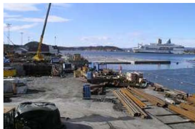
Bjørvikatunnel Oslo | Norway
