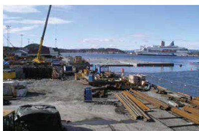
Bjørvikatunnel Oslo | Norway
