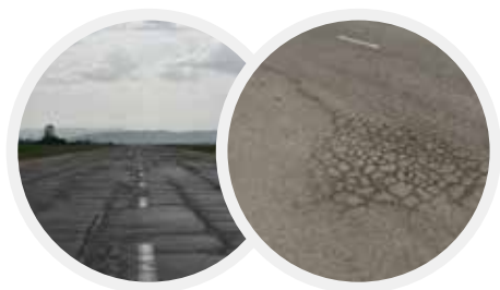
Παράδειγμα ρηγματώσεων για επισκευές σε μεγάλες επιφάνειες
