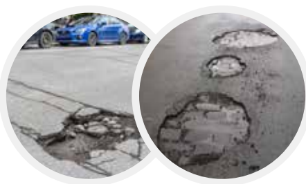
Παράδειγμα ρηγματώσεων για τοπικές επισκευές
